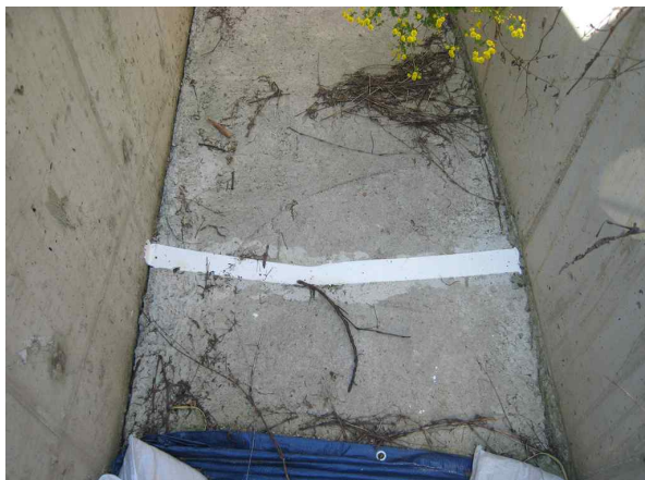
시점측 갭문 배수로 균열 보수완료-문산방향
