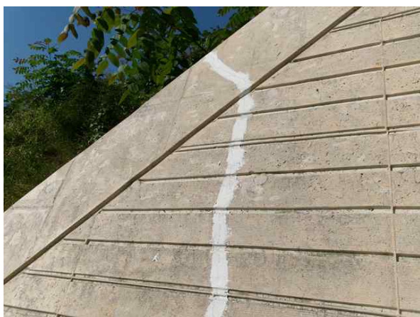
시점측 갭문 균열보수-서울방향
