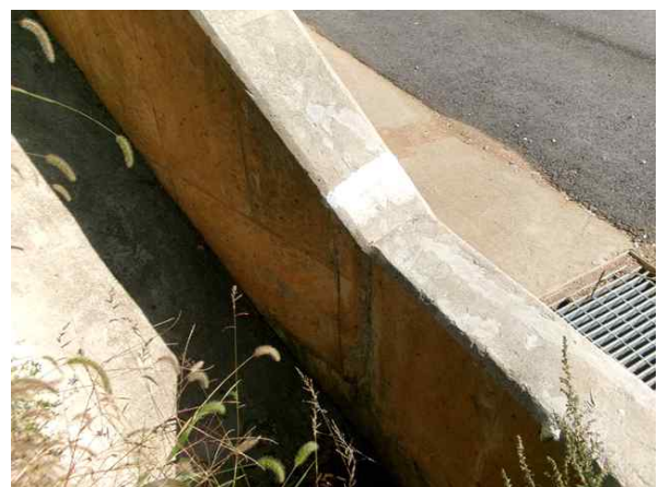
시점측 갭문 균열보수-서울방향
